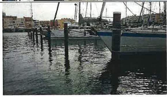
Ducs d'Albe partiellement corrodés (pontoon I)
