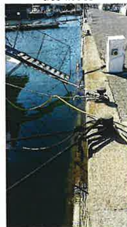
Fissure et tassement quai entre bassins 6 et 7 Etat des lisses
