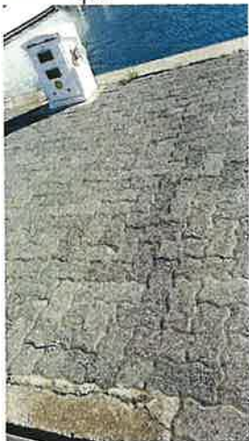
Fissure et tassement quai entre bassins 6 et 7
