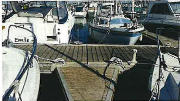
Catway sur 2 éléments de pontoon (pontoon N)
