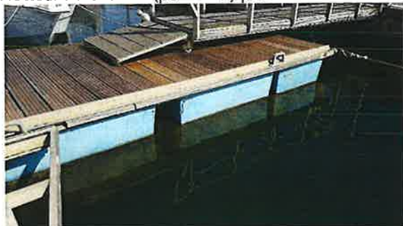
Flotteur FV éventré (pontoon K) pas d'accès PMR
